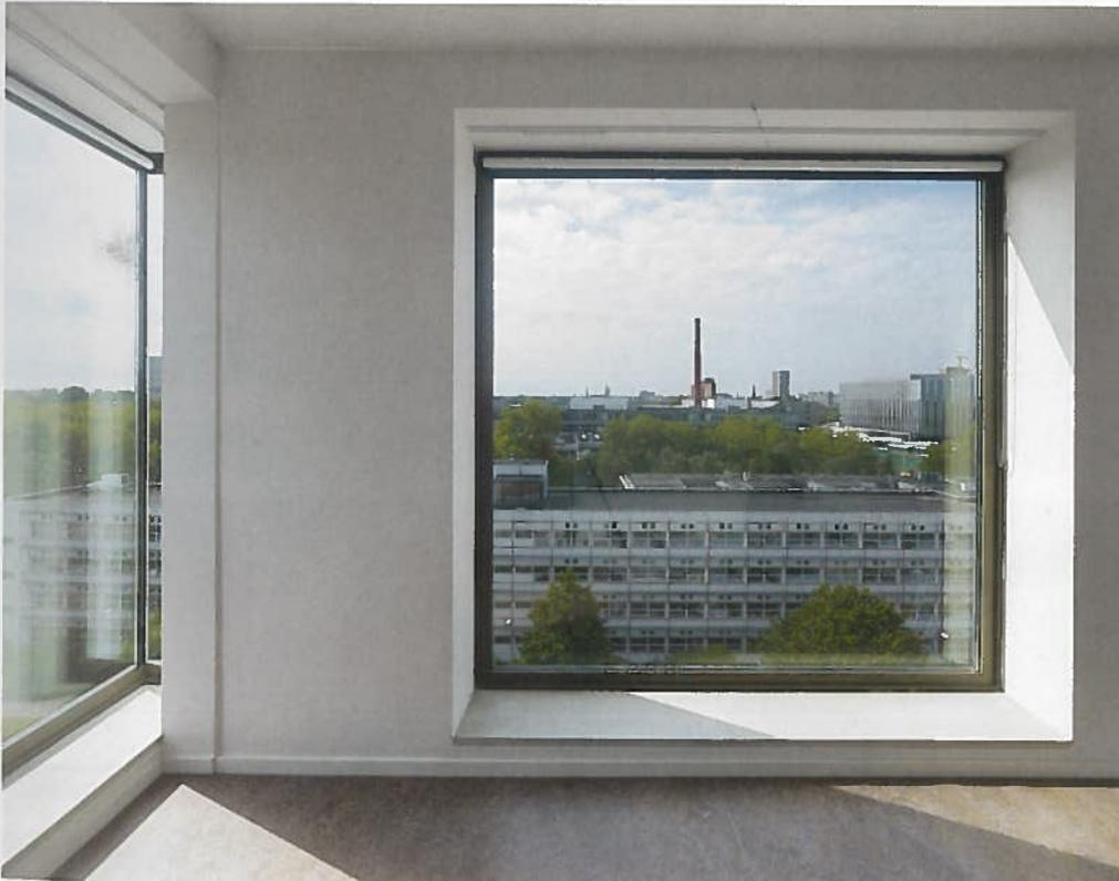
Die gerichtete Tragstruktur der Vorfabrikation entlastet die Schmalseiten des Gebäudes. Das wird räumlich genutzt, um die nicht tragende Seite aufzubrechen.
